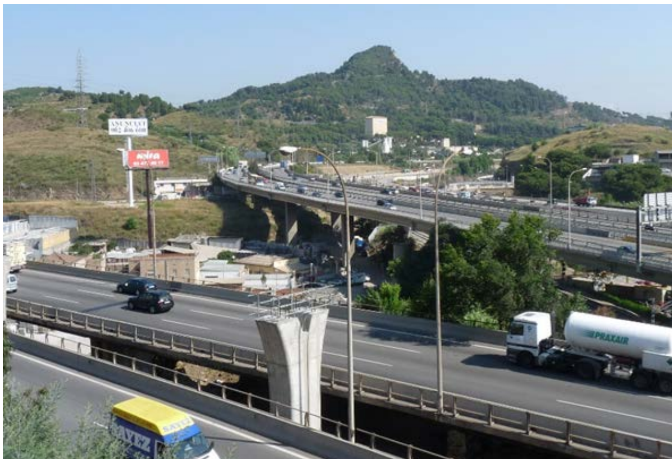
Imatge 25. Feix d'infraestructures entre el turó de Montcada i el turó de Cant Sant Joan
